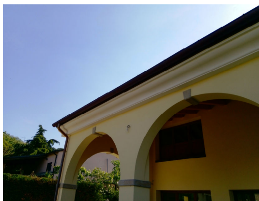
Cornice finita dopo la pittura elastomerica.
