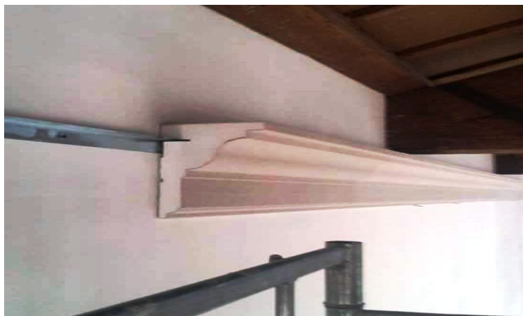
Esempio di fissaggio meccanico di un profilo decorativo Decormat.
