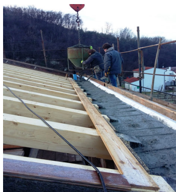
Fase del getto in calcestruzzo.
