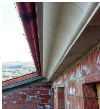
Cornice dopo lo scassero.
