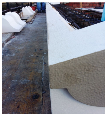
Montaggio della cornice.
